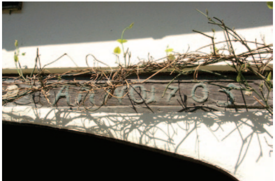
Den gamla portbjälken med det inhuggna byggnadsåret är fortfarande bevarad.
