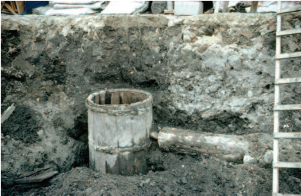
Denna tunna med anslutande träledningsrör påträffades vid utgrävningar för ett nybygge utmed Själbodgatan året 1975. Tunnan är en enkel vattenreningsbehållare från 1700-talet.
