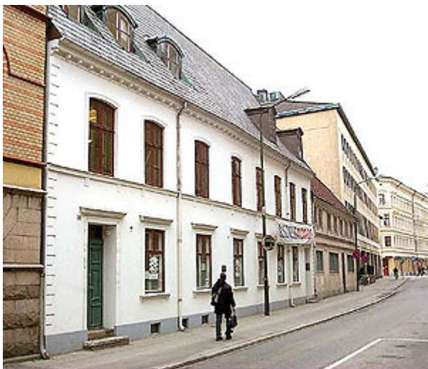
Huset närmast på bilden inrymmer Teatermuseum och är från 1400-talet. År 1497 krossades ett av fönstren på andra våningen.
